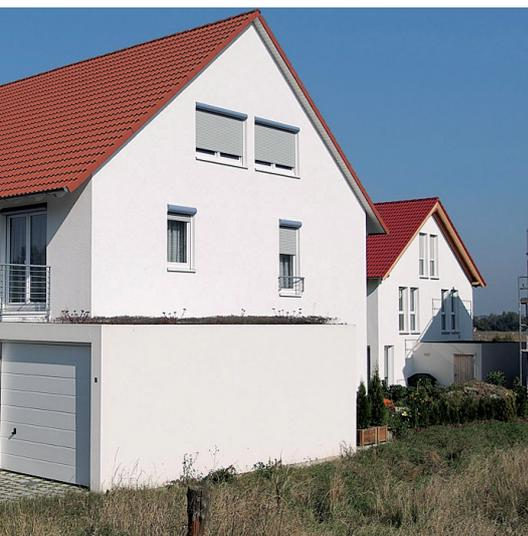
Betonfertiggaragen bieten sich besonders für extensive Dachbegrünung an, da sie ohne einen zusätzlichen Aufbau und nur mit einer dafür ausgelegten Dachabdichtung zu bepflanzen sind.
